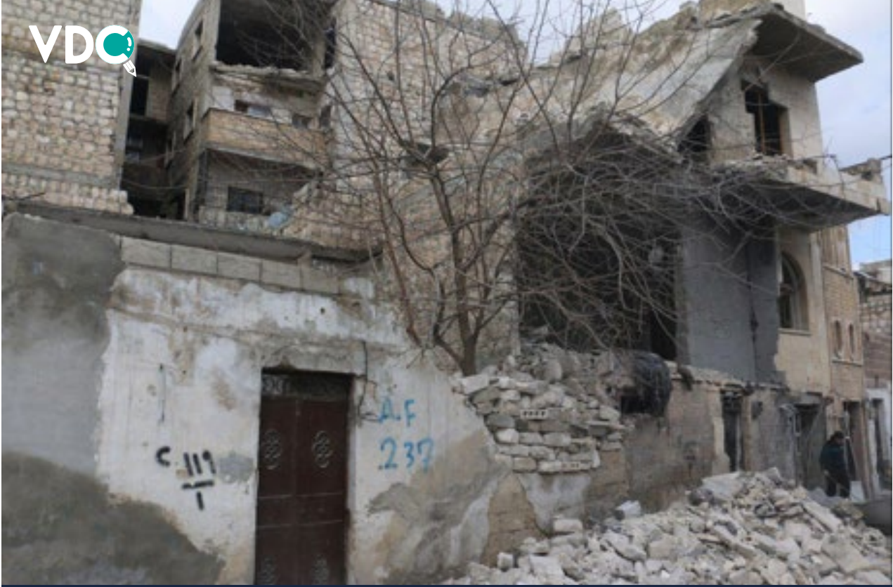
دمار أحد المنازل نتيجة القصف الذي تعرض له الحي الجنوبي في مدينة معرة النعمان المصدر : مراسل مركز توثيق الانتهاكات في ريف إدلب | 19/2/2019
