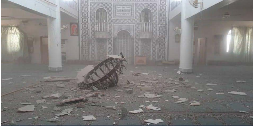
تضرر حرم مسجد الرحمن الداخلية نتيجة قصف قوات الحكومة السورية بتاريخ 7 حزيران/ يونيو 2019 المصدر : الدفاع المدني السوري
