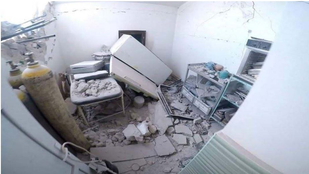
حجم الدمار الذي لحق بمشفى الرحمة نتيجة استهدافه بتاريخ 21 آب / أغسطس 2019 المصدر : مديرية صحة إدلب
